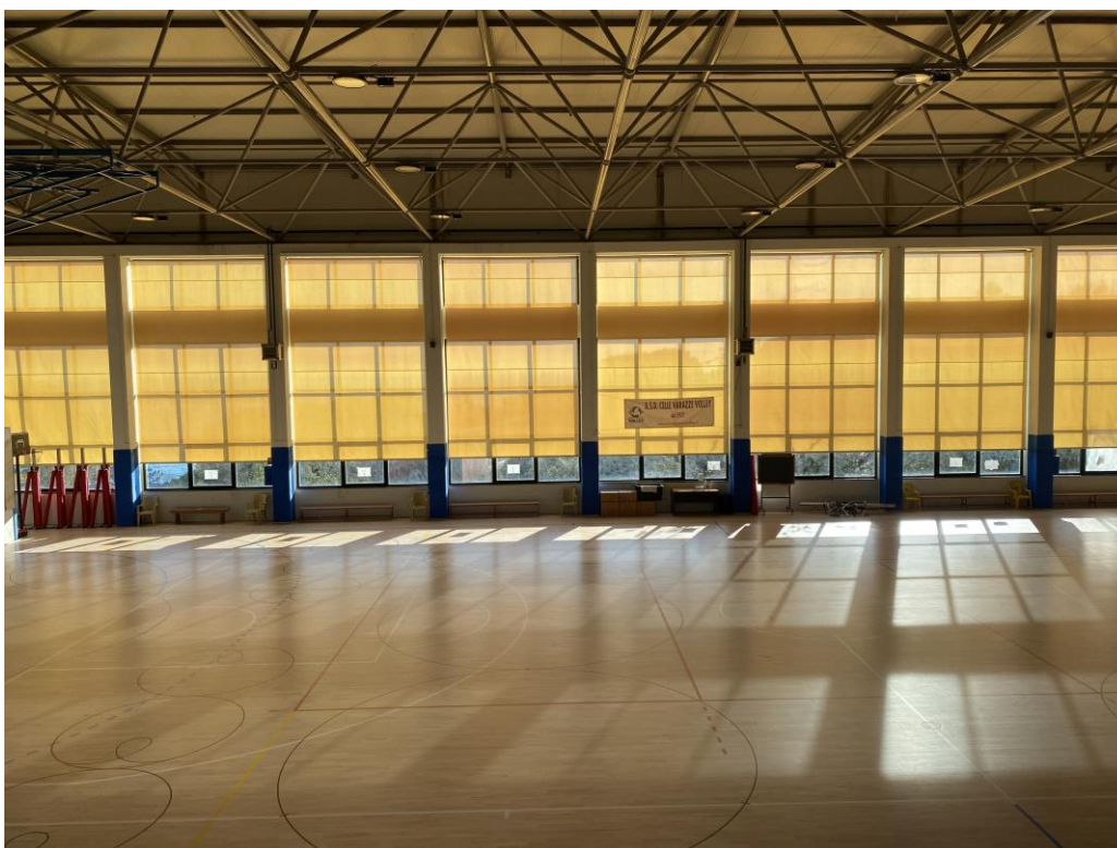
Una vista della fine lavori al Palazzetto dello Sport
