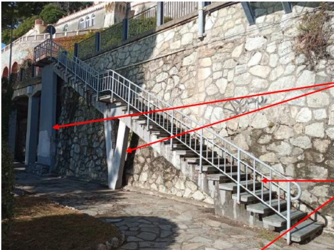
Ripristino CLS setti
