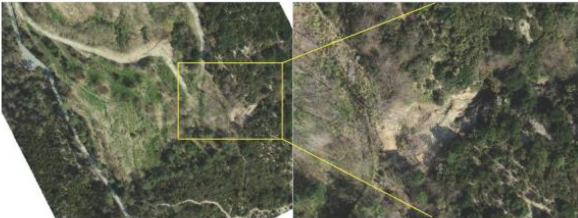
Foto 2.5, 6: Vista della zona in frana mediante volo drone e particolare del dissesto
