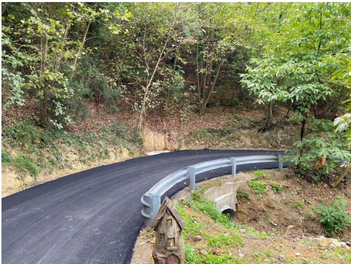
regimazione acque e asfaltatura del tratto
