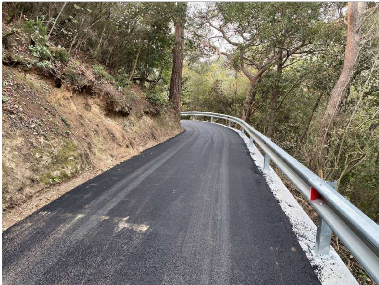
Getto cordolo e sistemazione stradale con guard rail e asfaltatura ( vista da monte vs valle)
