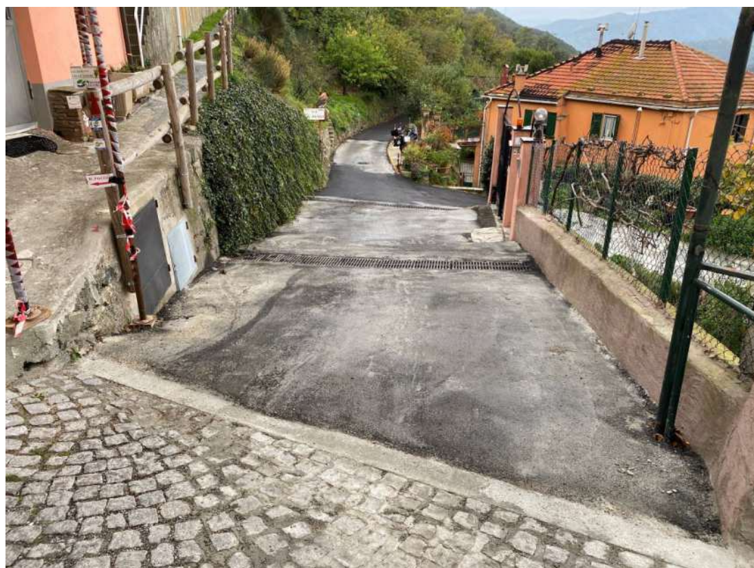
Realizzazione lavori: Imbocco di Via Santuario della Pace- Cordolino di collegamento tra Piazza Giovanni XXIII e imbocco Via Santuario della Pace e realizzazione griglie raccolta acque e tubazione di regimazione
