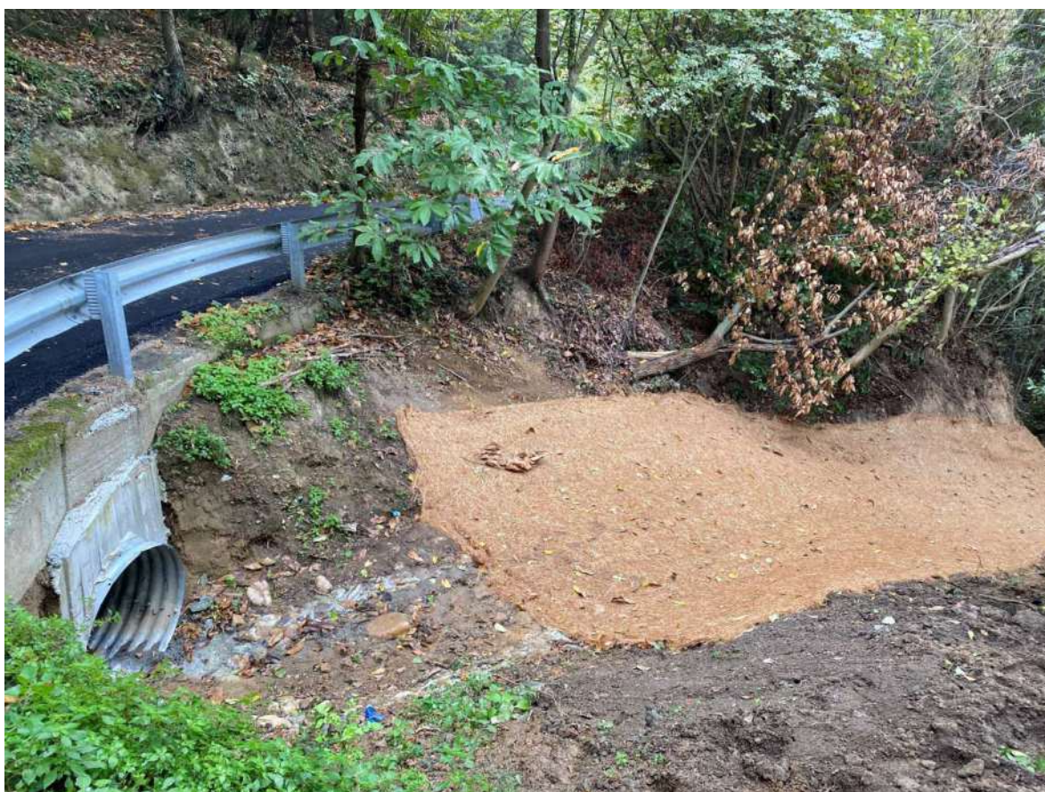
Posa stuoia in fibra di cocco sul fondo alveo/sponde a valle dell'immissione del finsider su Rio
