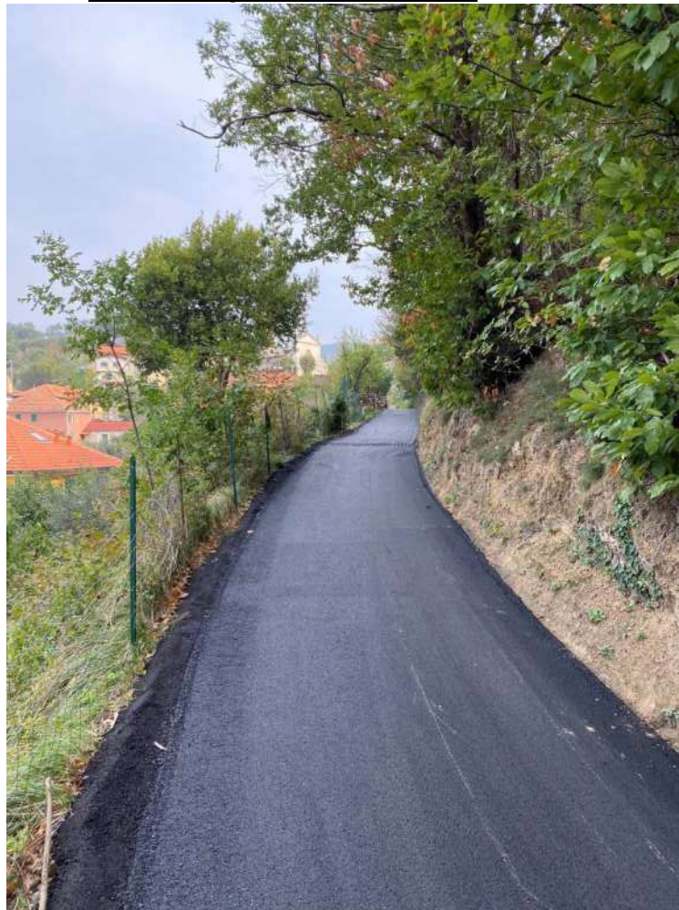
Realizzazione lavori: asfaltatura tratto (rif. foto 14 suddetta)
