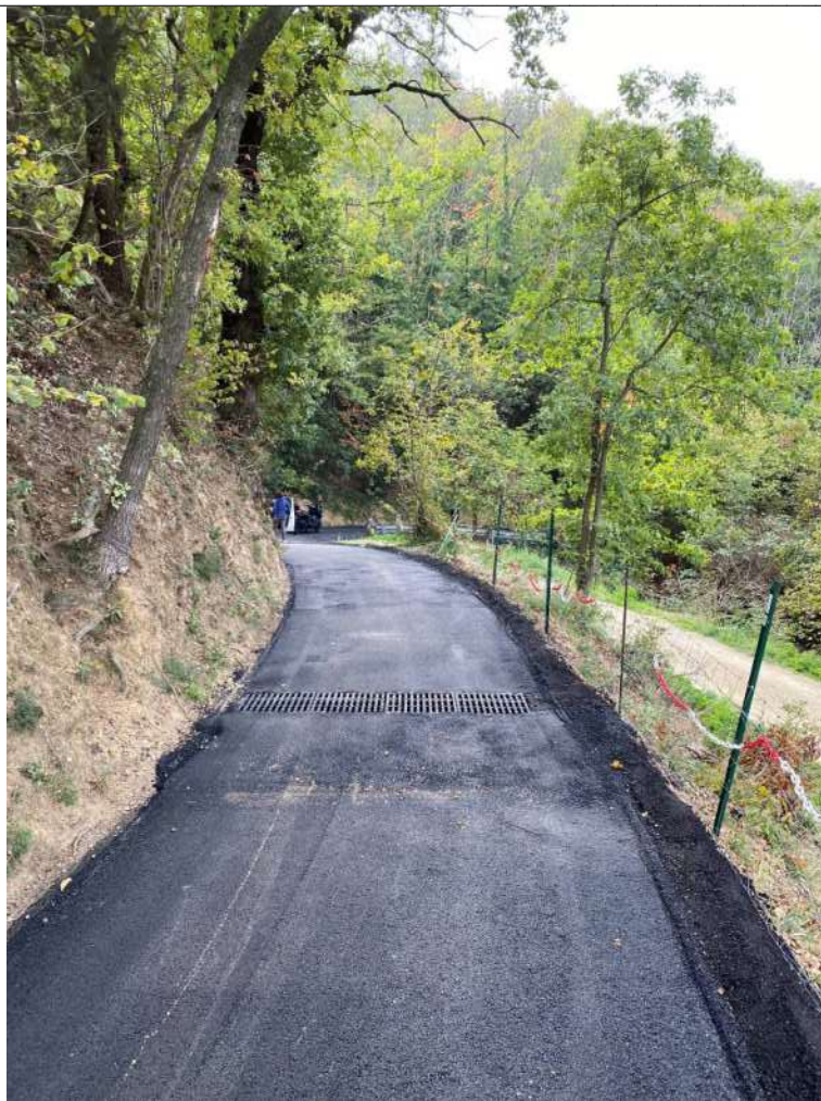
Realizzazione lavori: asfaltatura tratto (rif. foto 15 suddetta)
