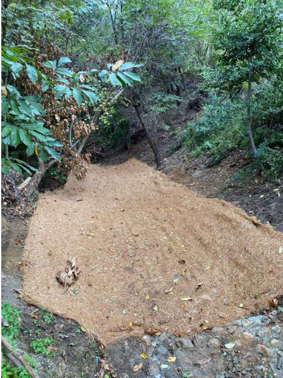
Posa stuoia antierosiva e pulizia spondale ( da arbusti e alberature)
