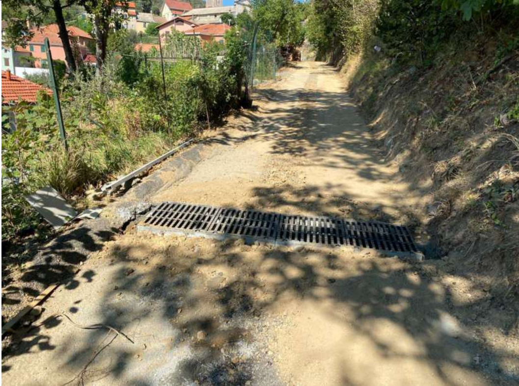
Realizzazione lavori: fasi esecutive posa in opera canalizzazione di regimazione acque nel tratto
