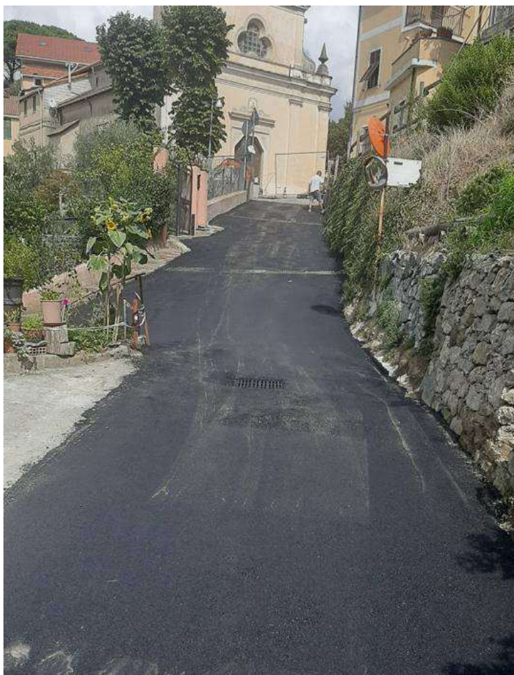
Realizzazione lavori: asfaltatura tratto (rif. foto 12 suddetta)
