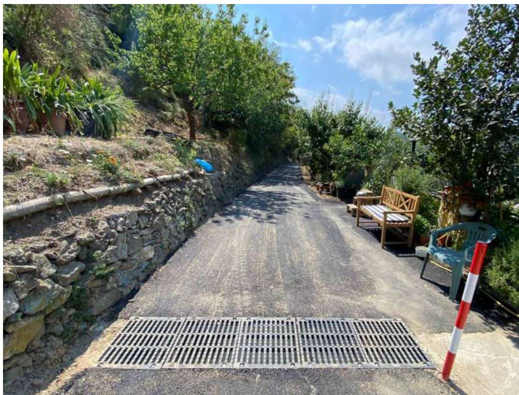
Realizzazione lavori: asfaltatura tratto (rif. foto 13 suddetta)
