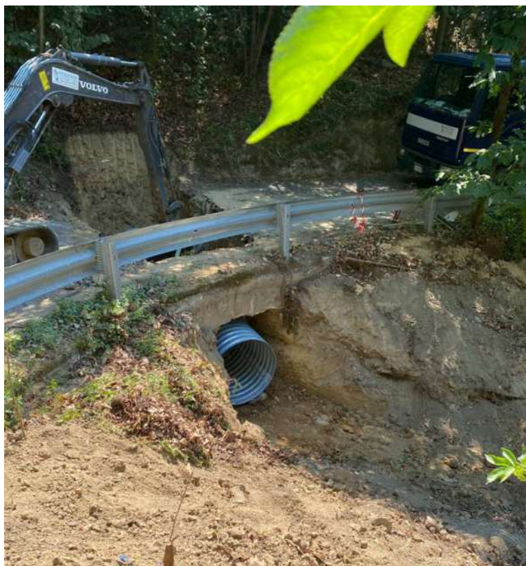
Realizzazione lavori: Posa in opera finsider
