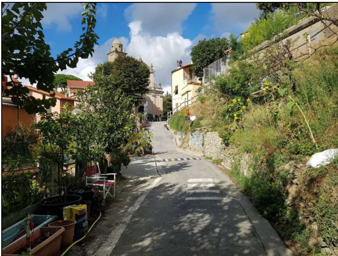
Stato dei luoghi antecedente lavori Foto n. 13 - Tratta di Via Santuario della Pace a valle dell'intersezione con Via Privata Cerisola
