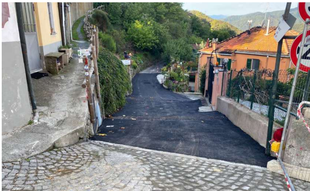
Realizzazione lavori: Imbocco di Via Santuario della Pace Realizzazione regimazione acque con posa tubazione e griglie di raccolta acque , con eliminazione griglia su imbocco di Piazza Giovanni XXIII
