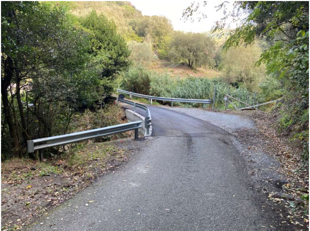
Installazione guard-rail bordo strada ( su entrambi i lati)
