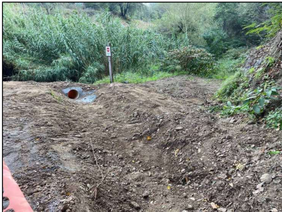
Realizzazione regolarizzazione raccolta acque bordo strada
