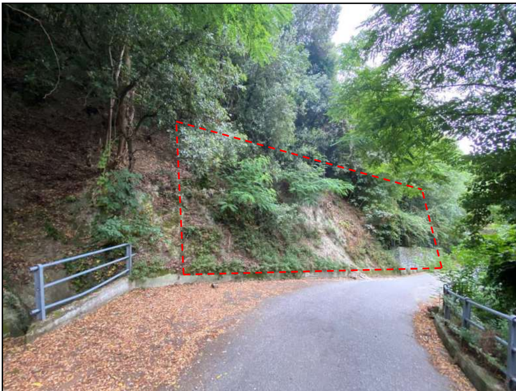
Versante di monte soggetto a rafforzamento corticale
