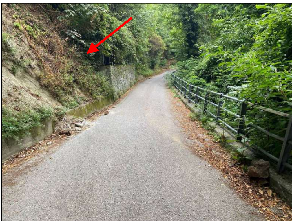
Versante di monte soggetto a rafforzamento corticale
