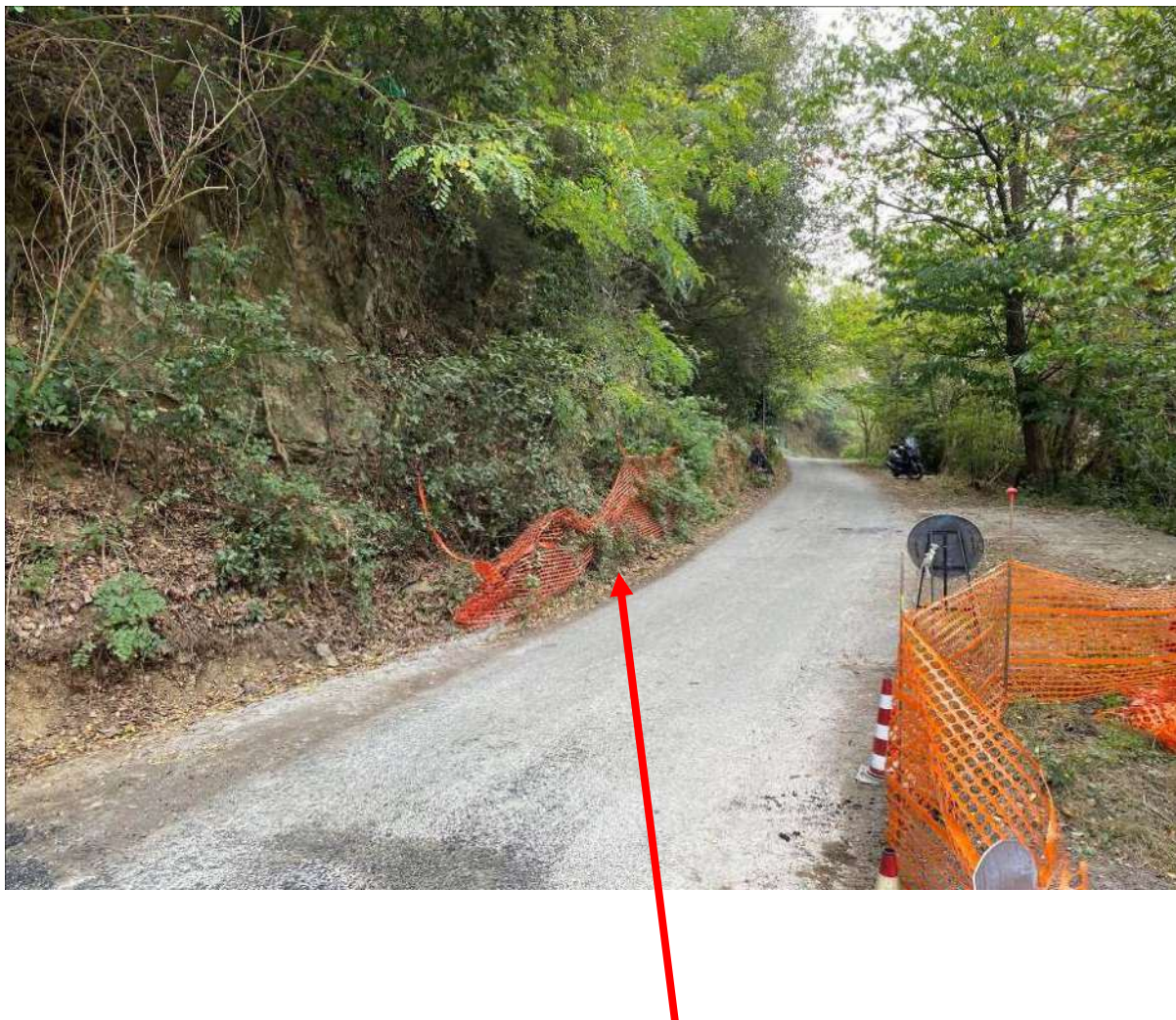
Rimozione recinzione bordo strada lato monte e pulizia cuneette (strada x Gameragna)- vedi foto a seguire riferita a stato antecedente lavori
