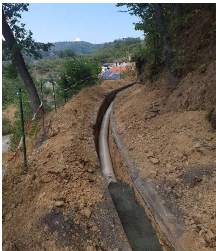
Realizzazione lavori: Posa in opera tubazione diam. 315 mm in PVC per regimazione acque
