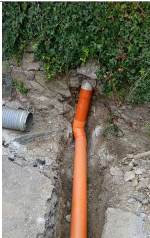
Realizzazione lavori: collegamento tra esistente tubazione bordo strada alla nuova tubazione di regimazione delle acque su Via S.Pace
