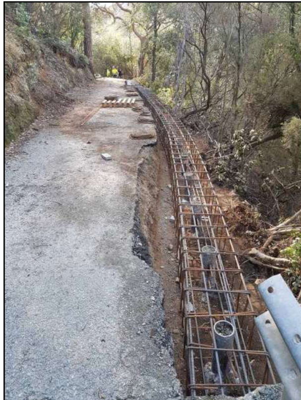
Armatura cordolo testa palo in c.a
