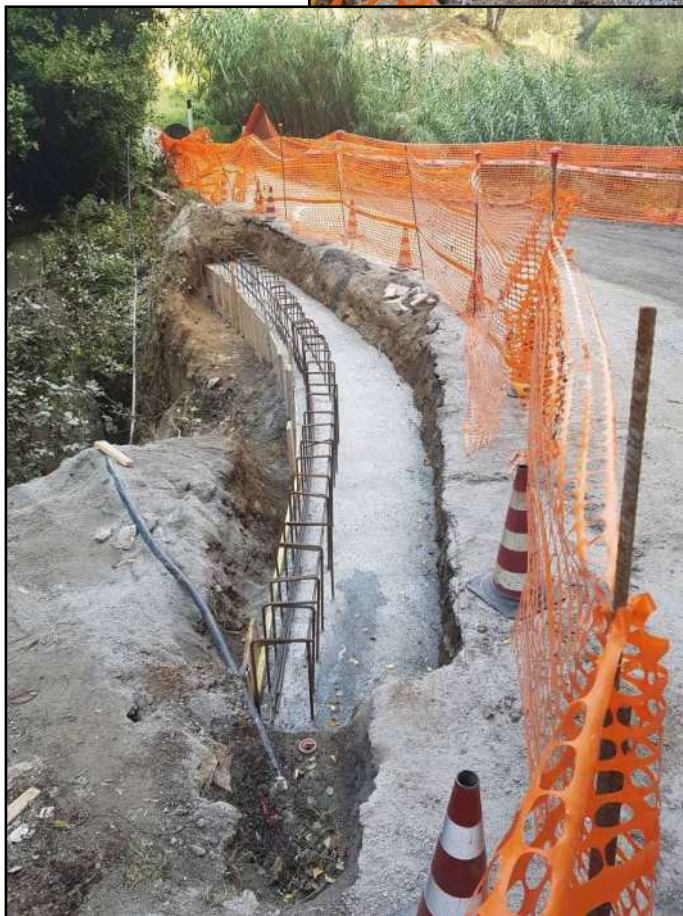
Realizzazione cordolo su pali bordo strada lato valle
