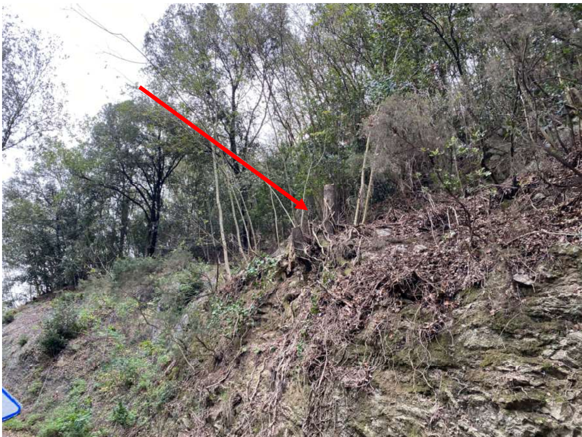
Taglio alberature insistenti su imbocco Via Santuario della Pace ( da valle)
