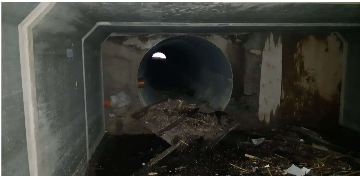
Foto 1: vista da monte verso valle del raccordo tra il tratto di tombinatura già adeguato e la porzione di canale provvisorio circolare
