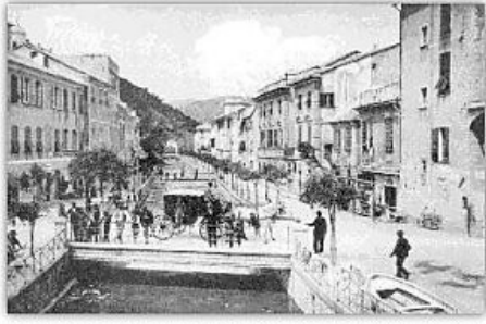
Primi anni del '900 - Veduta del ponte costruito nel 1896 sul torrente Ghiare. Sulla destra la sede comunale e le scuole elementari (ora occupate dal Bar Margherita e dall'Albergo Impero). Sulla sinistra, il palazzo Ferri - Bravetti, già Albergo Milano, ora sede Municipale
